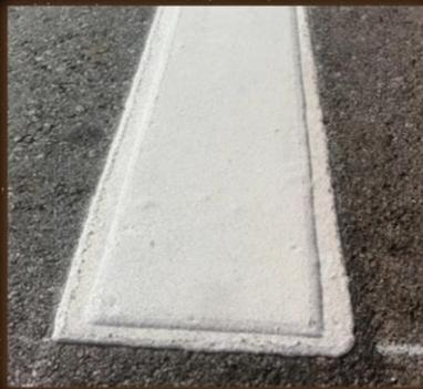
La nostra proposta del 2014 di installazione di una banda sonora in fresatura a cavallo della riga bianca ha prodotto risultati eccezionali: riduzione incidenti mortali del 75%.
